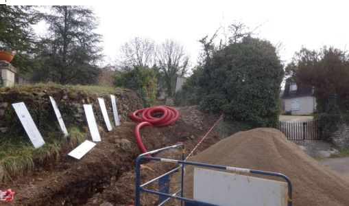
Mise en souterrain des réseaux et alimentation du nouveau transformateur du lotissement du Barry du Fraysse
