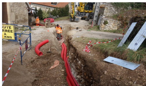
Mise en souterrain des réseaux et alimentation du nouveau transformateur du lotissement du Barry du Fraysse
