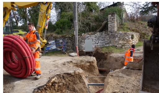
Mise en souterrain des réseaux et alimentation du nouveau transformateur du lotissement du Barry du Fraysse
